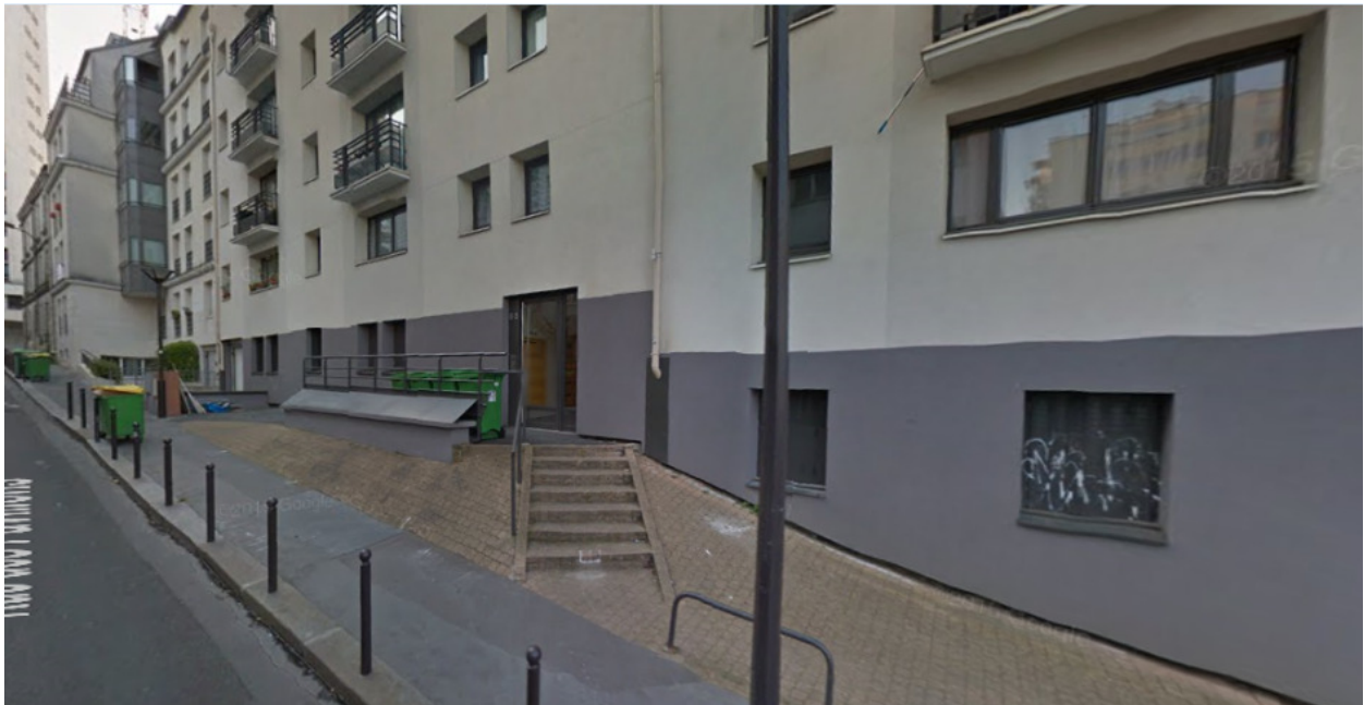
Rue des Pavillons, Paris
